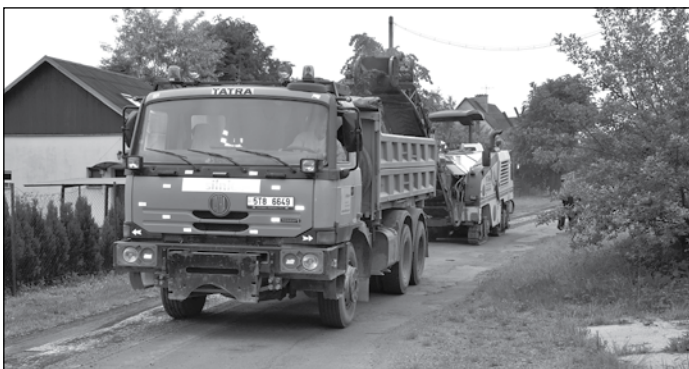
Úprava podkladu cesty u továrny.
